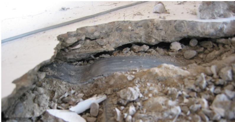
*Bild 4.25:* Detailaufnahme im Bereich einer abgelösten Betonscholle
