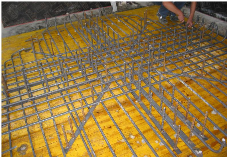
*Bild 5.1:* Verlegen der HFV-Anker und der Biegebewehrung
