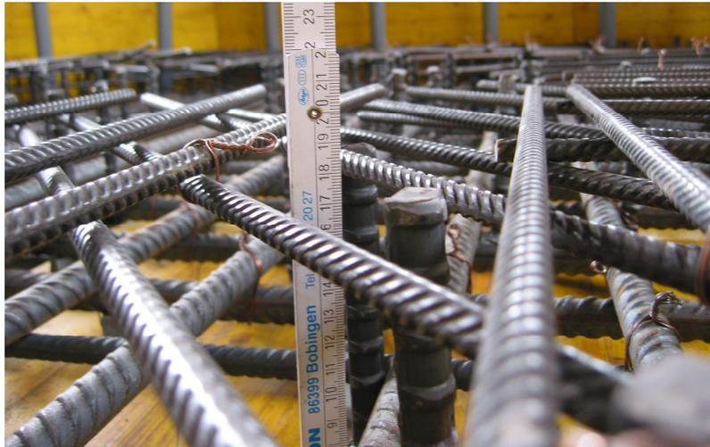
**Bild 4.35:** Höhenlage eines eingebauten HFV-Ankers
