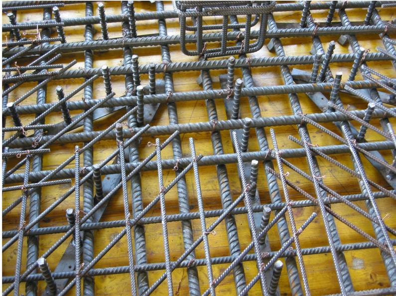
*Bild 4.82:* HFV-Anker der Versuchsplatte 20-III
