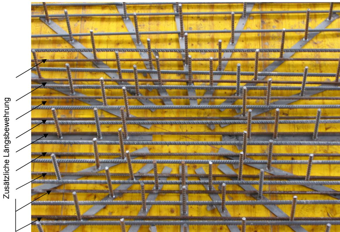
**Bild 5.94:** Bereich um den Stützenstumpf mit zusätzlicher Längsbewehrung
