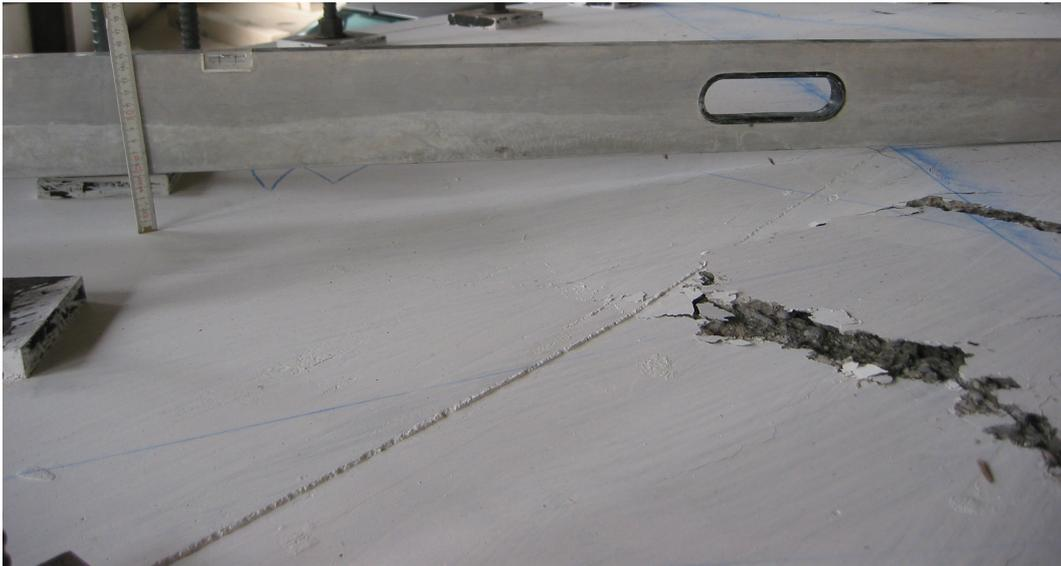
*Bild 4.22:* Herausgedrückte Betonscholle an der Plattenoberseite
