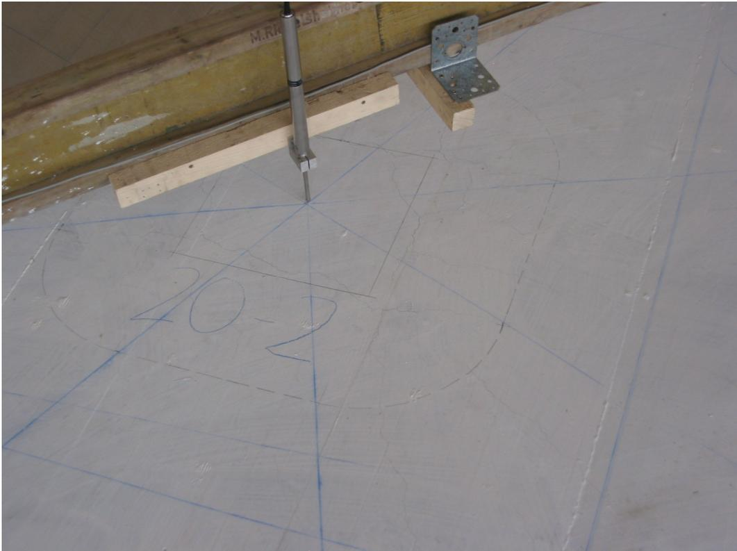
**Bild 4.50:** Risse an der Plattenoberfläche im Bereich des Stützenstumpfs
