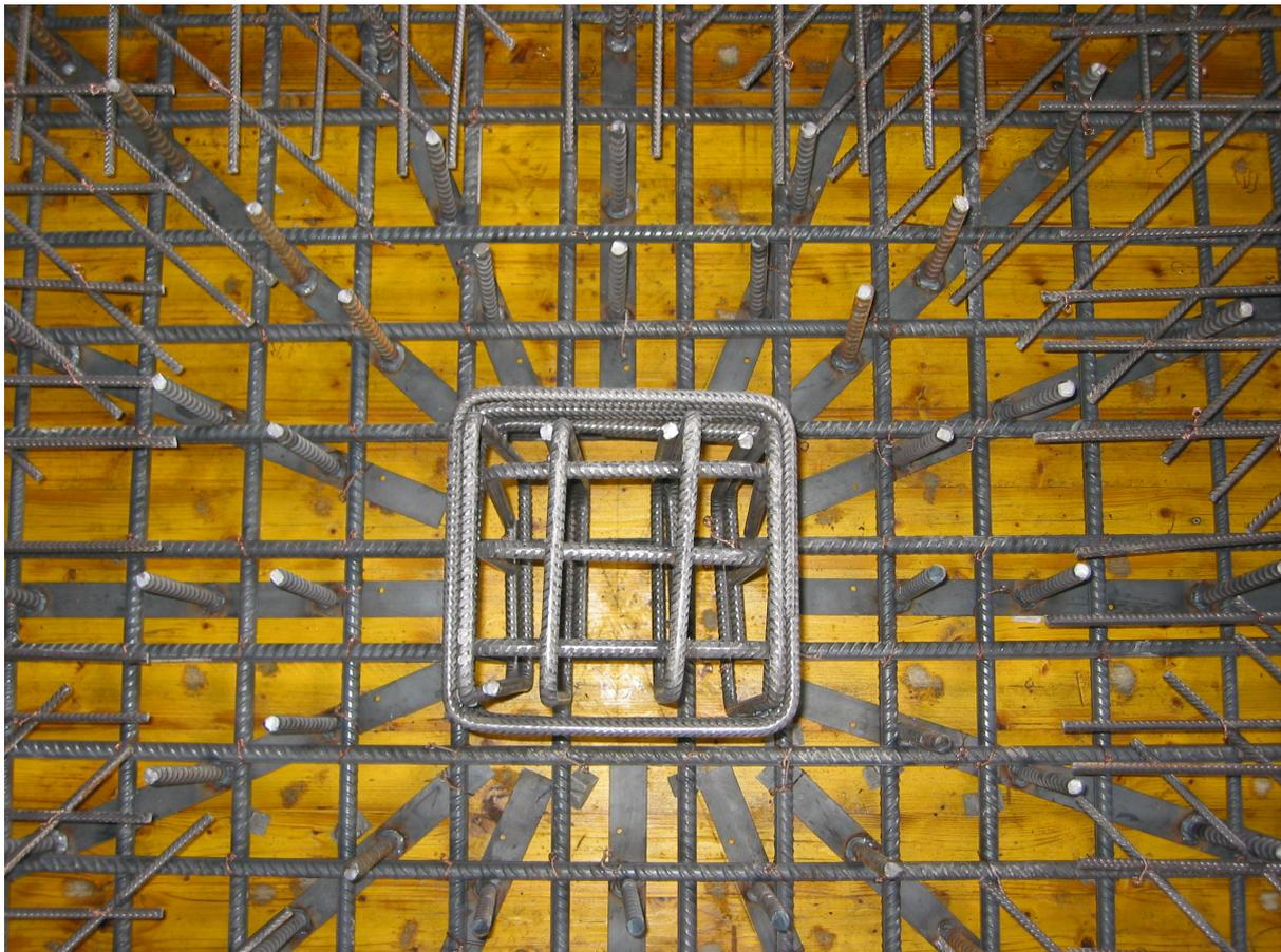
*Bild 5.48:* Rotationssymmetrische Verlegung der HFV-Anker
