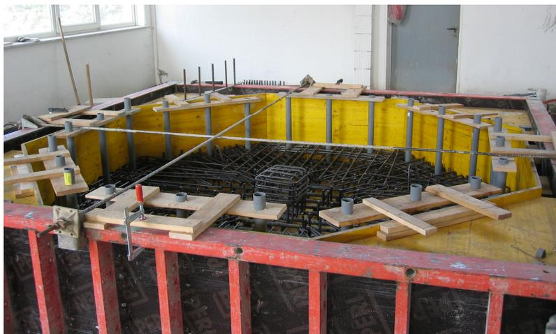
*Bild 4.4:* Zum Betonieren vorbereiteter Schalungskörper der Platte 20-I
