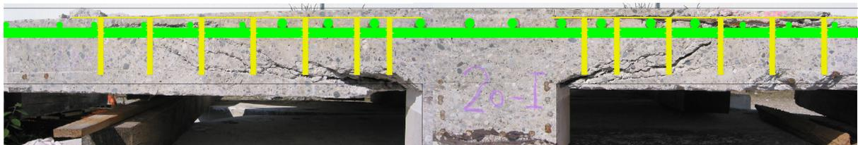
**Bild 4.30:** Querschnitt der Platte 20-I mit eingezeichneten HFV-Ankern
