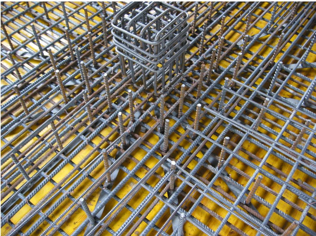
*Bild 6.1* HFV-Anker der Platte 30-III
