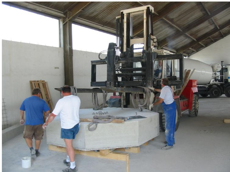
*Bild 2.9:* Auflegen der Widerlagerplatte auf die Unterkonstruktion
