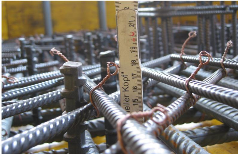
*Bild 4.84:* Höhenkontrolle eines eingebauten HFV-Ankers
