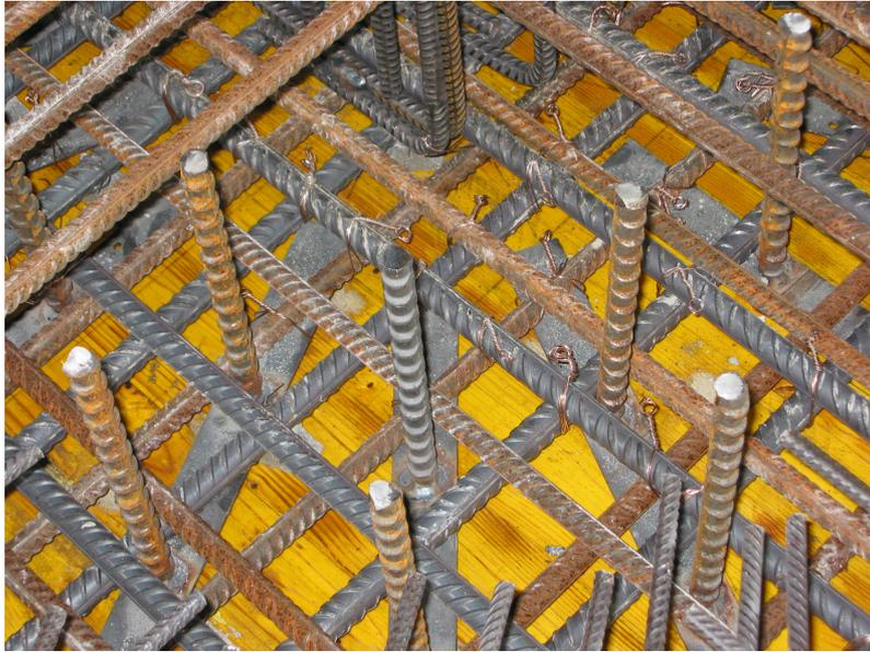
*Bild 5.96:* Engmaschig verlegte Biegebewehrung mit HFV-Ankern
