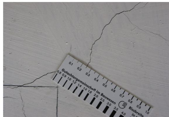
**Bild 4.94:** Rissweiten im Bereich des Stützenstumpfs in Höhe der rechnerischen Gebrauchslast
