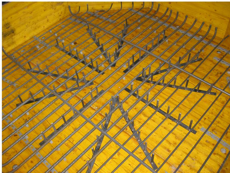
*Bild 4.2:* HFV-Ankerleisten mit unterster Lage der Biegebewehrung
