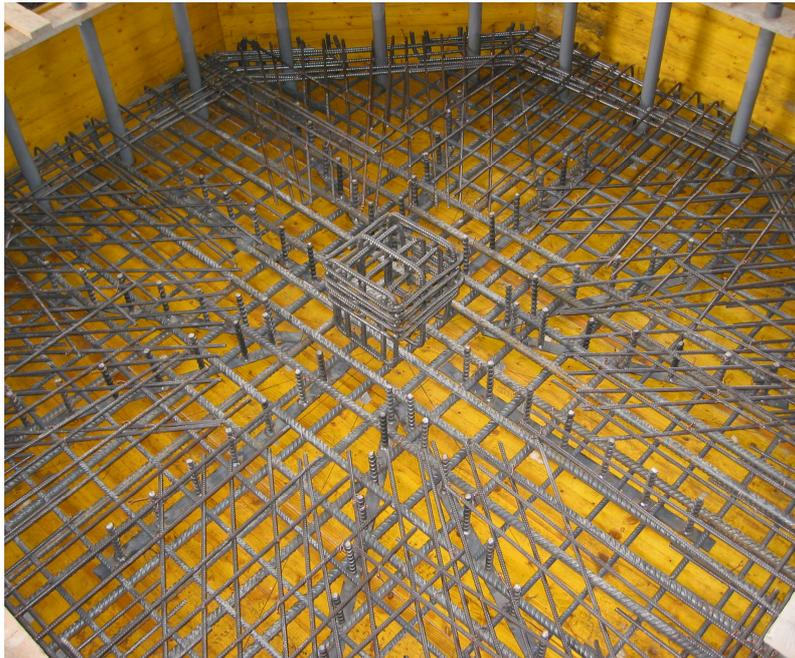
*Bild 3.6:* Eingebaute HFV-Ankerleisten
