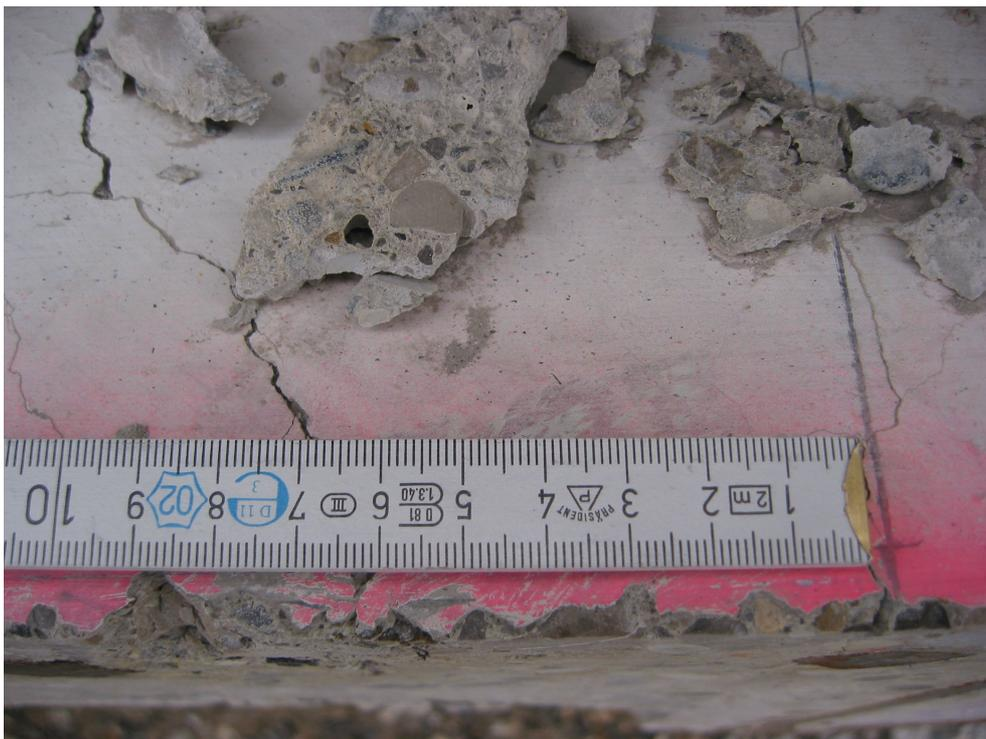
*Bild 4.80:* Gemessener Rissabstand von 6 cm an der Plattenoberseite
