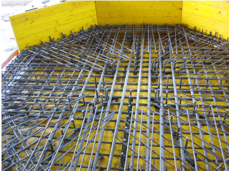
*Bild 4.3:* Verlegte Bewehrung der Durchstanzplatte 20-I
