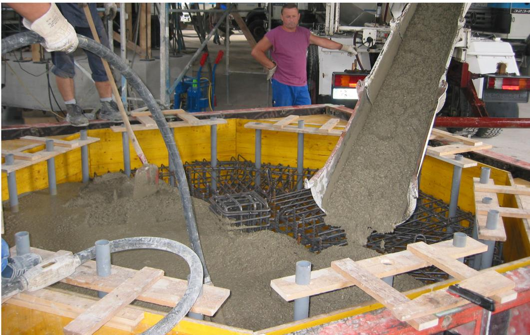
**Bild 5.4:** Betonieren der ersten 30 cm starken Versuchsplatte
