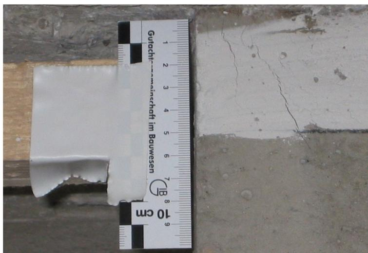
**Bild 4.112:** Messlineal am Stützenstumpf mit neuem Riss
