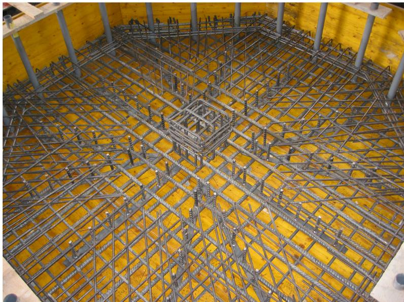
*Bild 4.34:* Fertig bewehrte Versuchsplatte 20-II
