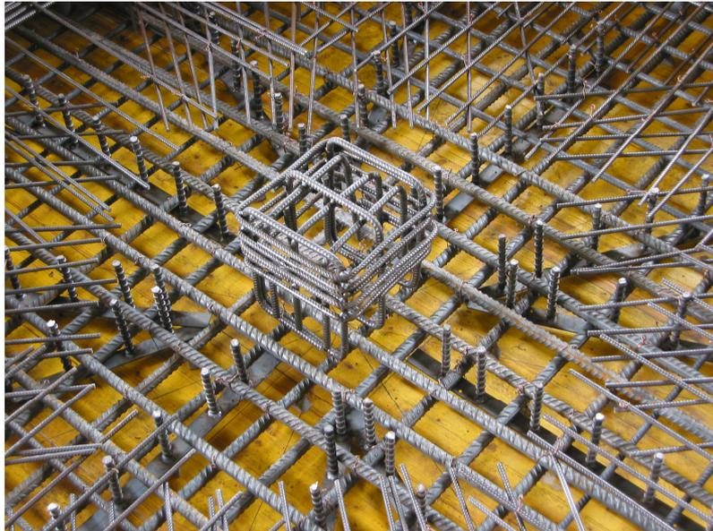
*Bild 4.33:* Annähernd rotationssymmetrisch verlegte HFV-Anker
