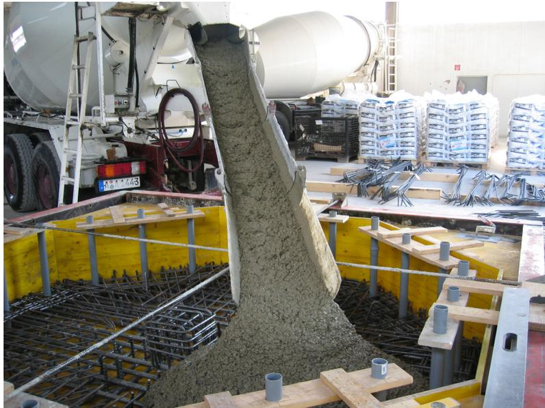
*Bild 4.5:* Betonieren der Versuchsplatte 20-I
