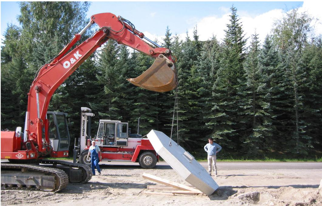
*Bild 5.97:* Drehen der Platte mit Hilfe eines Baggers im Außenbereich
