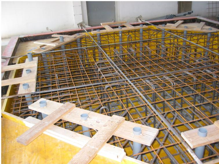
*Bild 2.7:* Eingebaute Bewehrung der Widerlagerplatte
