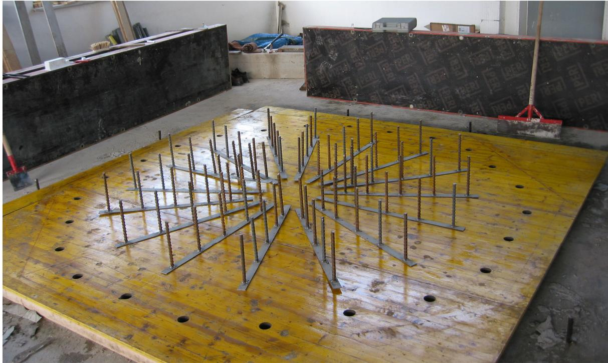
**Bild 5.93:** Rotationssymmetrisch verlegte HFV-Anker
