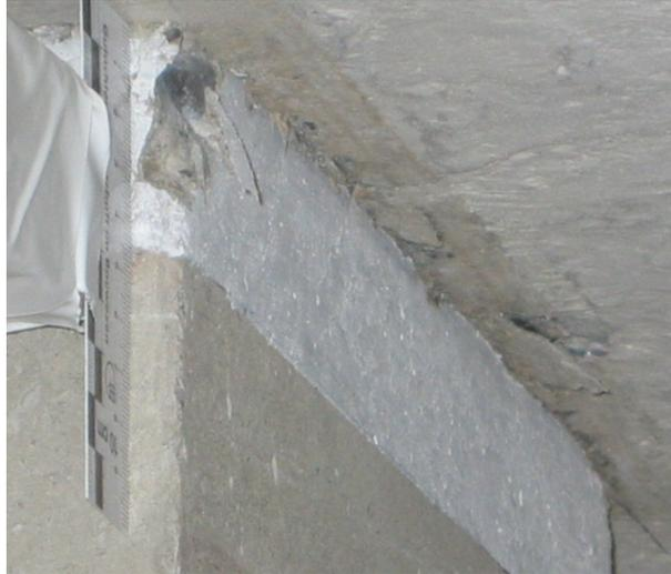
**Bild 5.80:** Abplatzungen beim Stützenstumpf an der Plattenunterseite
